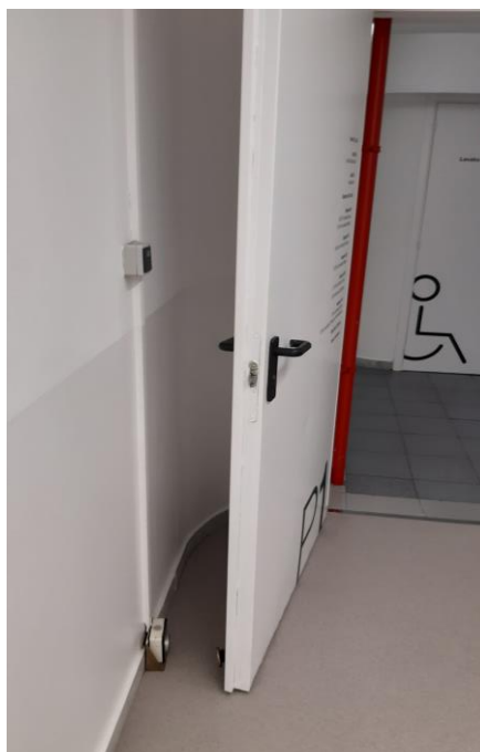
Tancament porta no garantit en cas emergència i desactivació electroimant
